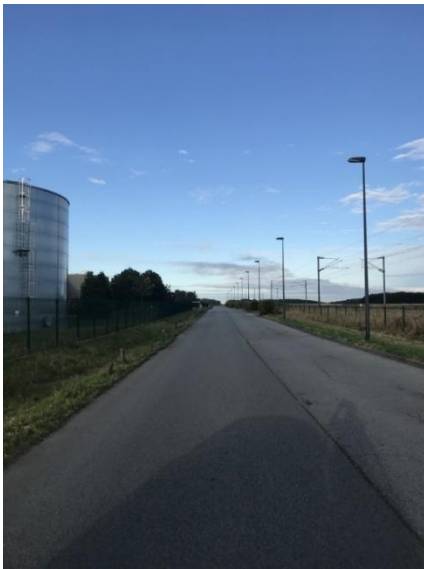
Illustration 11 : Voirie interne à la ZAC déjà réalisée entre l'échangeur central et le site SEGUREL (rue du parc)
