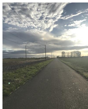
Illustration 16 : Photo de la voirie actuelle à l'Est (vers Paris). Elle sera élargie
