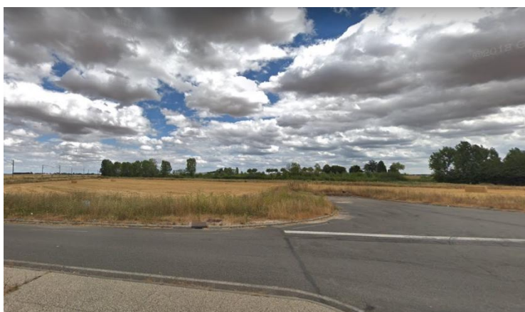
Illustration 15 : Amorce actuelle de voirie déjà réalisée sur le carrefour central, aménagements à poursuivre vers l'Est
