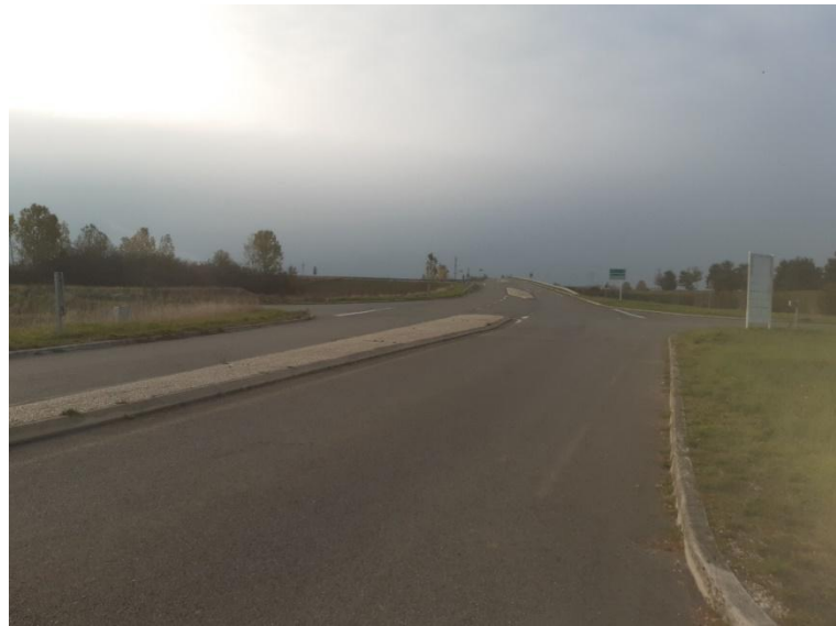
Illustration 12 : Echangeur central réalisé dans la ZAC (route départementale RD 136B)
